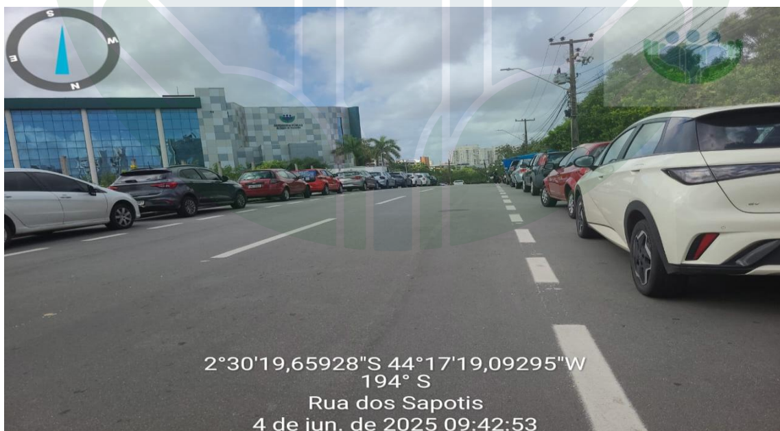
Imagem 12 – Veículos estacionados junto ao meio-fio da via, reduzindo a largura disponível para a utilização (largura útil), diminuindo a capacidade da mesma ;
