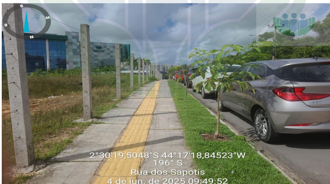
Imagem 14 – Veículos estacionados junto ao meio-fio da via, reduzindo a largura disponível para a utilização (largura útil), diminuindo a capacidade da mesma e impactando negativamente a imagem da instituição perante o público atendido .
