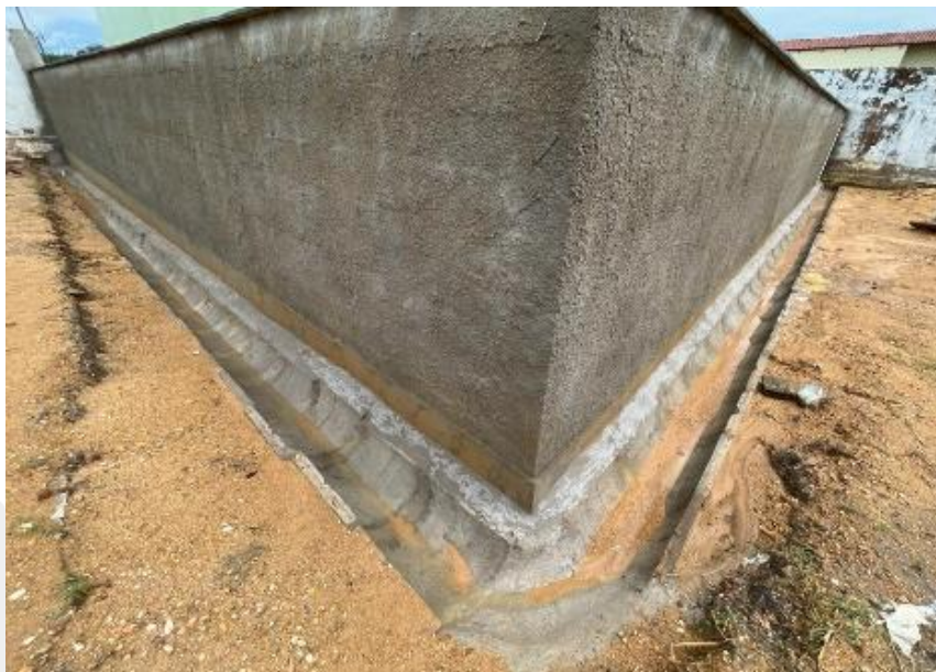
Imagem 05: canaleta de drenagem pré-moldada;
