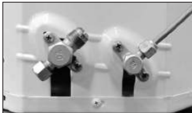
FIG. 35 - CONEXÃO DA LINHA DE EXPANSÃO DA UNIDADE CONDENSADORA
