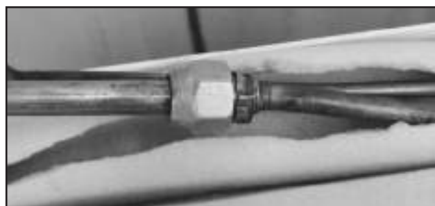
FIG. 37 - CONEXÃO DA LINHA DE SUCÇÃO DA UNIDADE EVAPORADORA
